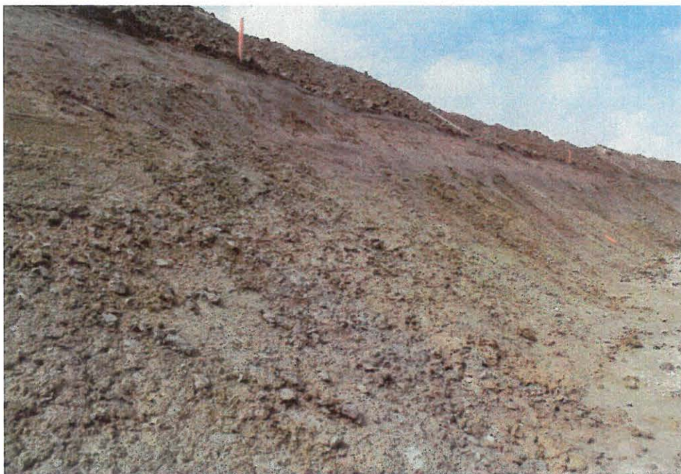
Abb. 44: Rieder Schichten: Im hangenden Abschnitt befindet sich eine ca. 50cm starke Deckschicht
