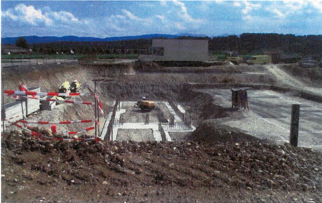
Abb. 31: Mittel- bis Grobkiessedimente im Baulos Krankenhausneubau Vöcklabruck (22. 08. 2001)
