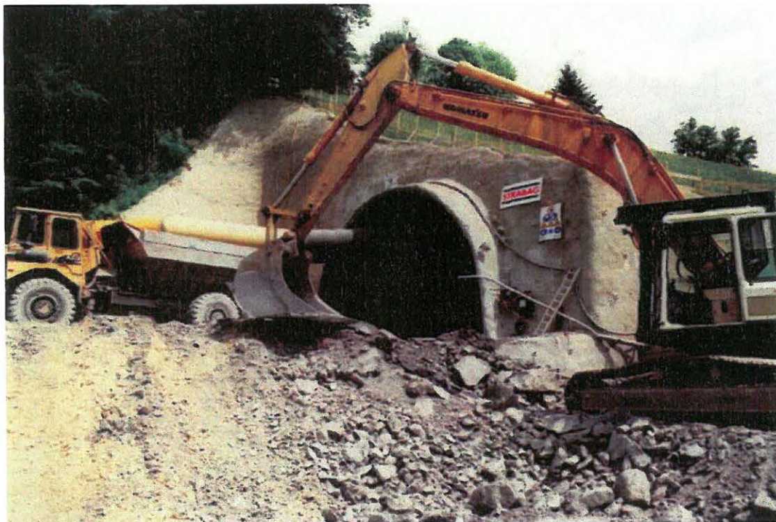
Abb. 56: Tunnel Losenstein, N-Portal mit Losensteiner Schichten im Abraumbereich (ÖK 69)
